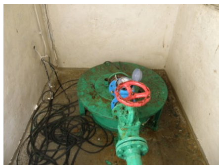
A MOL III-as kútjának nagy átmérőjű kútfeje
