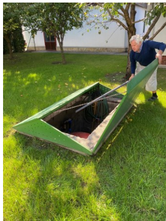
Különálló hidrofór-akna
