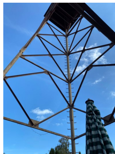
Kútakna feletti acél toronyszerkezet
