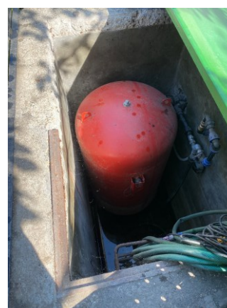
Különálló hidrofór-akna
